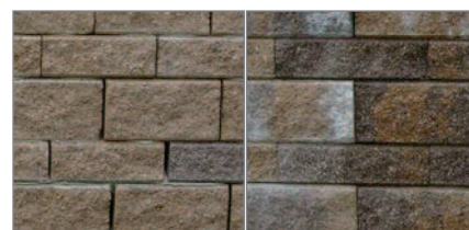
Kerítés hidrofobizált anyagból
